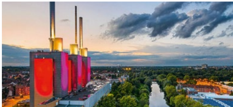
Die „Drei warmen Brüder“ - cogeneration plant Linden
